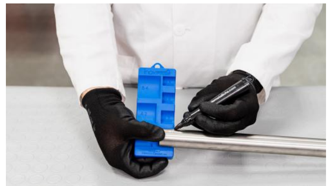
Figura 8 - Marcatura della profondità d'innesto
